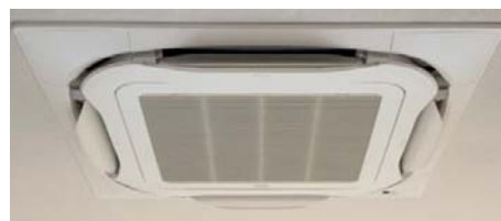
②空調機器 (エアコン、吸収式冷温水機、チラー)
