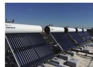
真空式太陽熱給湯システム
